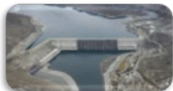
Grand Coulee 33 Units 6,684 MW*
