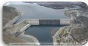
Grand Coulee 33 Units / 7,049 MW*
